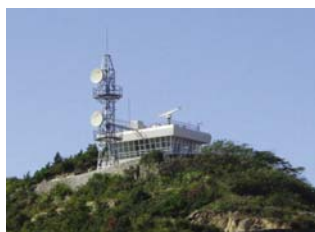
峙头雷达站 Zhitou Radar Station
