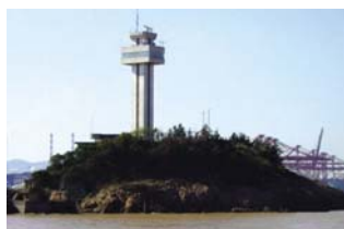
北仑山雷达站 Beilunshan Radar Station
